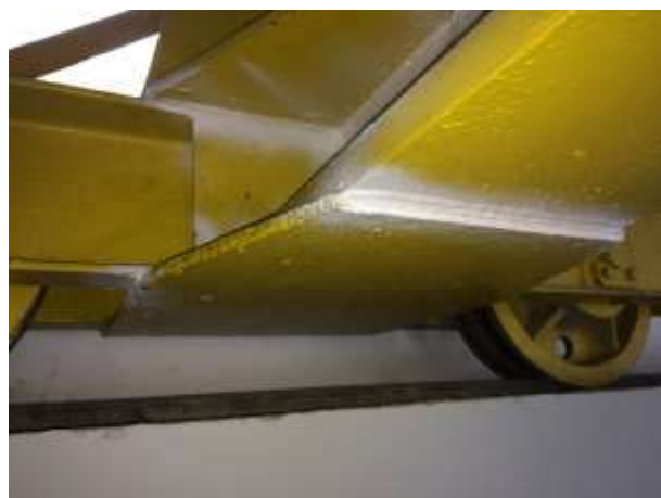
Controllo saldatura piastra coprigiunto ad intradosso - avanti
