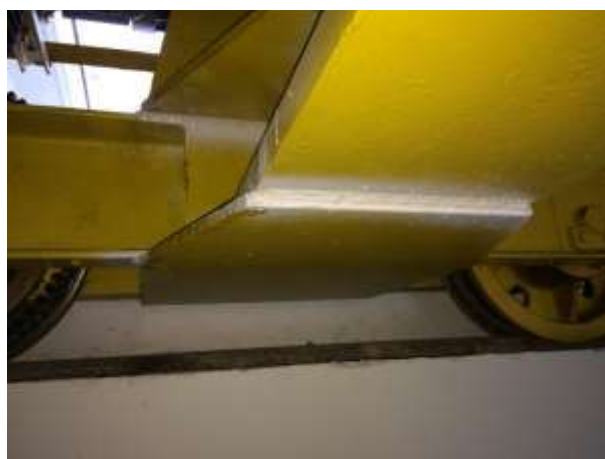
Controllo UT saldatura piastra di coprigiunto - indietro
