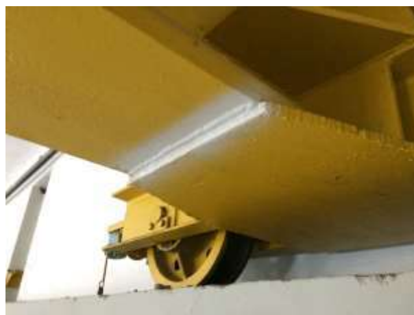
Controllo saldatura piastra coprigiunto inferiore
